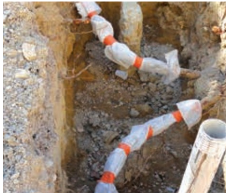
Protection des racines géomembrane contenant un substrat terreux humidifié (source : Charte Arbre de la ville de Montpellier)
